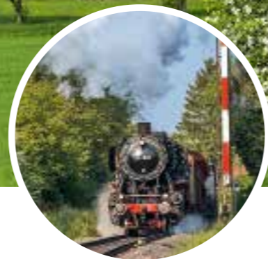
Das Eisenviadukt bei Epfenhofen im Kommental ist mit 264 Metern Länge und 34 Metern Höhe die größte Brücke der Strecke. Im Wechsel ziehen alte Diesel- und Dampflokomotiven den Zug
